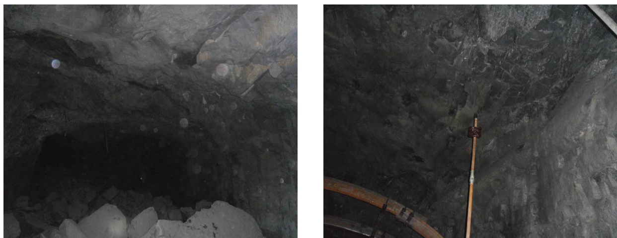
a) – the roof of ort delivery
